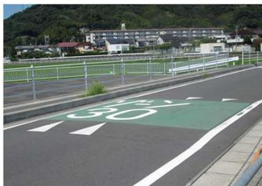
路側帯の設置・拡幅とグリーンベルトの設置
