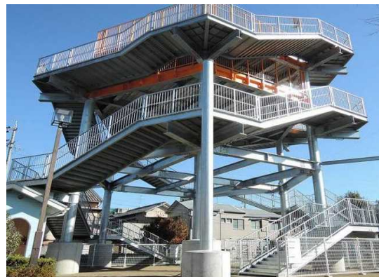
津波避難タワー (焼津市)
