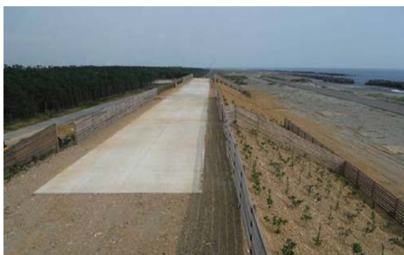
遠州灘に沿って整備される防潮堤（浜松市）
