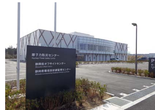
原子力防災センター（牧之原市）
