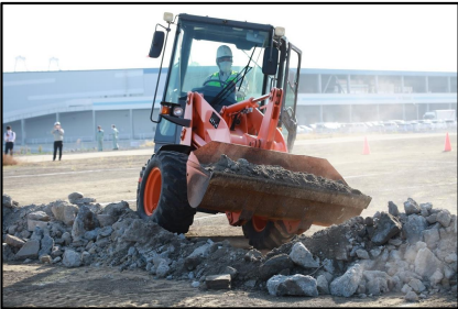
重機によるがれき撤去
