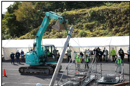
建設会社による倒壊電柱の撤去
