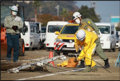
電線管理者による電線安全確認
