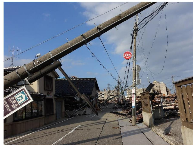
能登半島地震により倒壊した電柱
