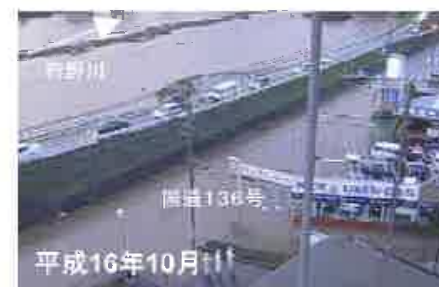
国道136号が内水氾濫により通行止め
