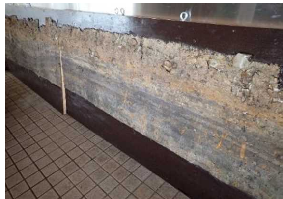
正倉基壇の土層転写
