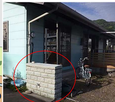
雨水貯留タンク設置事例
