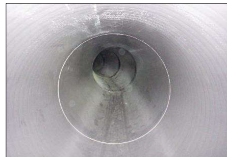
雨水管渠内部（内径1,800mm）
