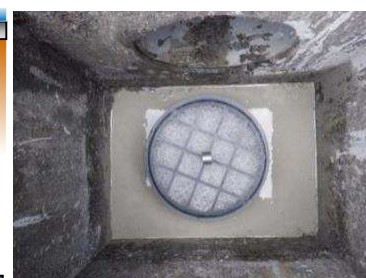
浸透管整備後の集水枳の内部
