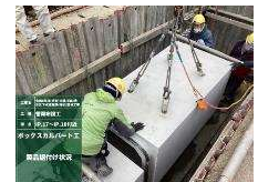
ボックスカルバート据付状況
