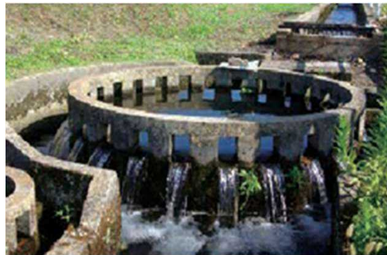
円筒分水による配水
