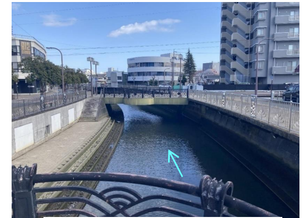
① タケル橋(県管理区間：0k600付近)
