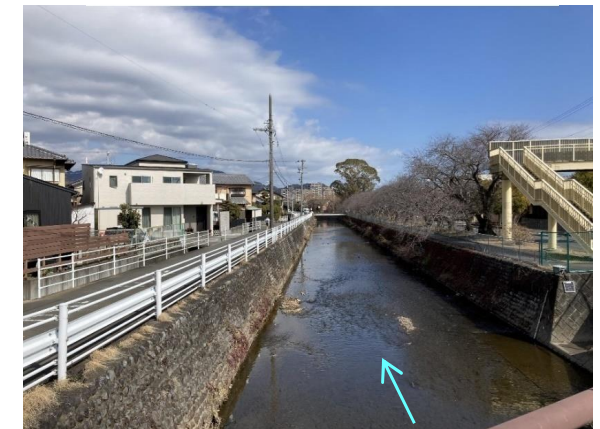
② 学童橋(県管理区間：1k500付近)
