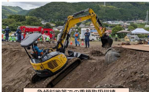
急傾斜地等での重機取扱訓練
