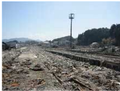
(東日本大震災被害写真)
