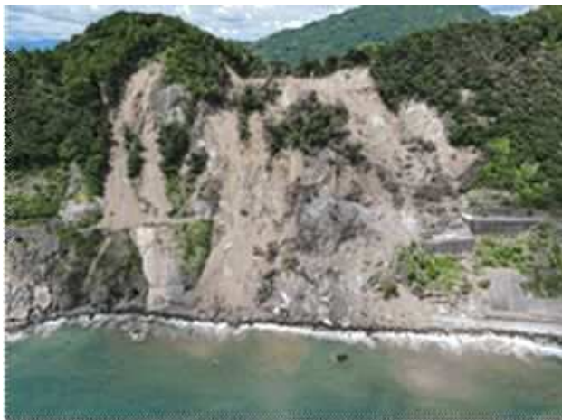
【崩壊した浜当目トンネルの外観】
