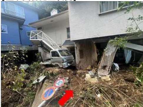
がけ崩れ(伊東市川奈)9月5日発生
