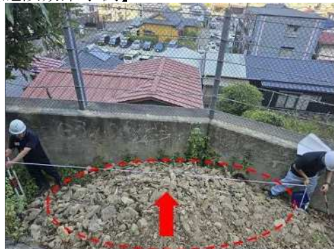
がけ崩れ(下田市西本郷)9月5日発生
