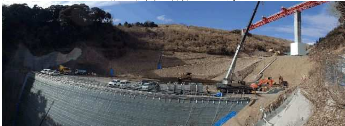
工事状況写真 令和7年1月20日撮影
