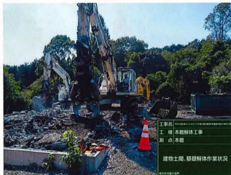
工事名: 本館解体工事 工種: 本館解体工事 測点: 本館 建物土間、基礎解体作業状況 株式会社 住友建設
