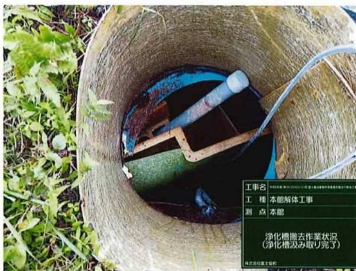
工事名 本館解体工事 工種 本館解体工事 測点 本館 浄化槽撤去作業状況 (浄化槽汲み取り完了)
