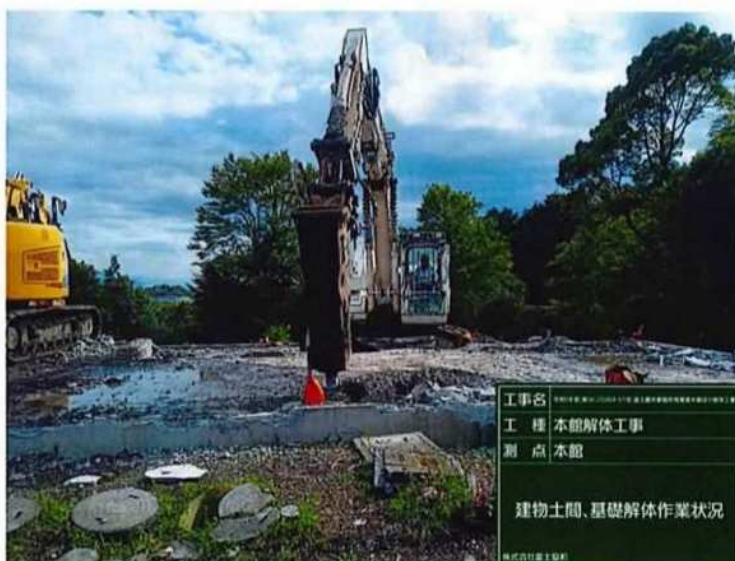
工事名 特別地域(第1種)における建築物等の解体工事(解体)等工事 工種 本館解体工事 測点 本館 建物土間、基礎解体作業状況 株式会社国土院
