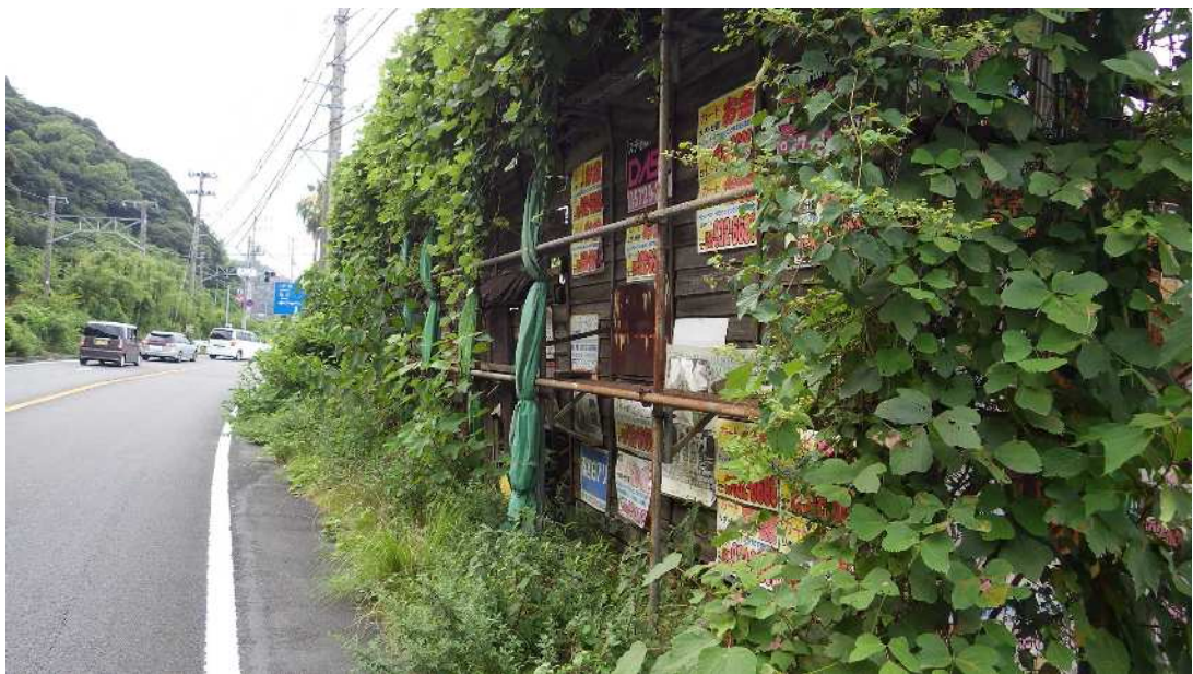
※現在、この建物は地下室の一部を除き伊東市が撤去済です。 H27. 7. 28熱海土木事務所撮影
