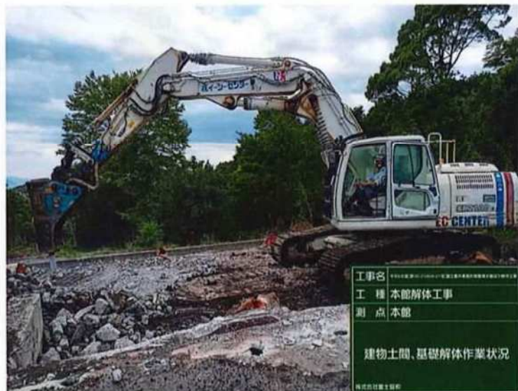
工事名: 本館解体工事 工種: 本館解体工事 測点: 本館 建物土間、基礎解体作業状況 株式会社 住友建設
