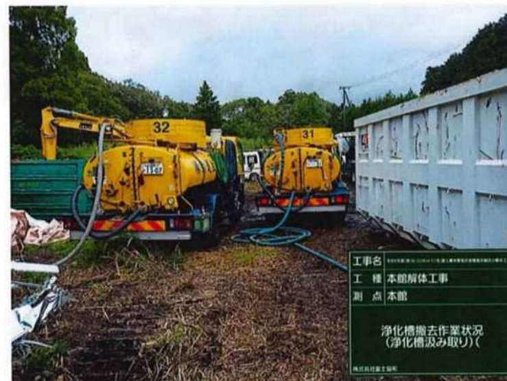
工事名 本館解体工事 工種 本館解体工事 測点 本館 浄化槽撤去作業状況 (浄化槽汲み取り)
