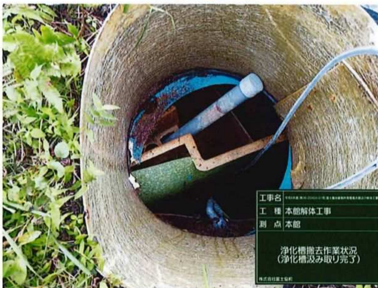
工事名 本館解体工事 工種 本館解体工事 測点 本館 浄化槽撤去作業状況 (浄化槽汲み取り完了) 株式会社 国土建設
