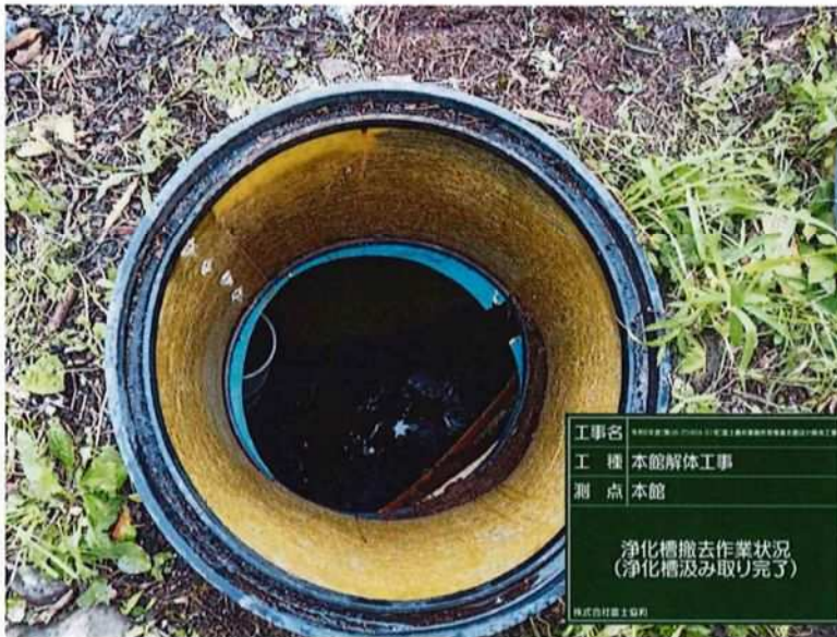
工事名 本館解体工事 工種 本館解体工事 測点 本館 浄化槽撤去作業状況 (浄化槽汲み取り) 株式会社 国土建設
