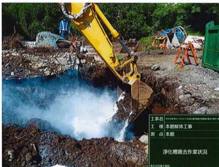
工事名 浄化槽撤去工事 工種 本館解体工事 測点 本館 浄化槽撤去作業状況 株式会社国土緑化
