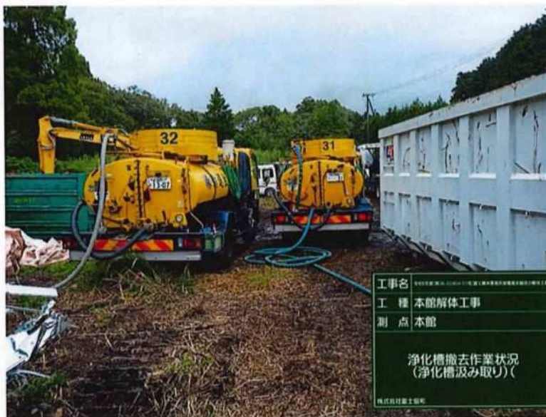
工事名 本館解体工事 工種 本館解体工事 測点 本館 浄化槽撤去作業状況 (浄化槽汲み取り) 株式会社富士建設
