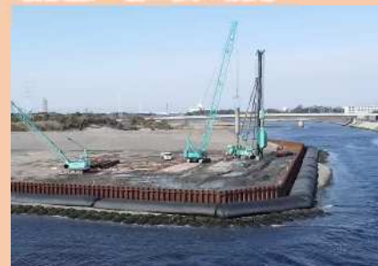
馬込川水門 仮締切工
