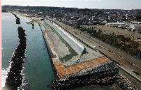
防潮堤の新設(相良海岸)
