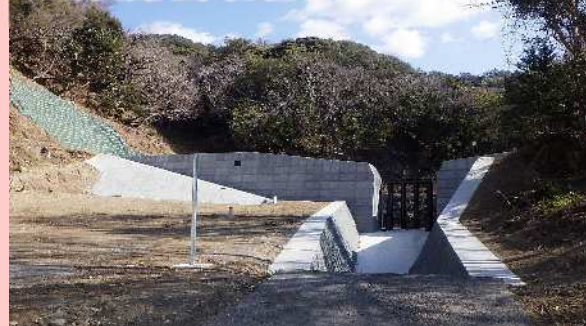
土砂災害対策(砂防堰堤)
