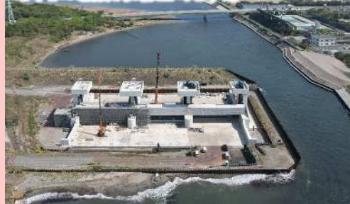
水門の新設(馬込川水門)
