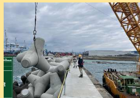
防波堤の整備
