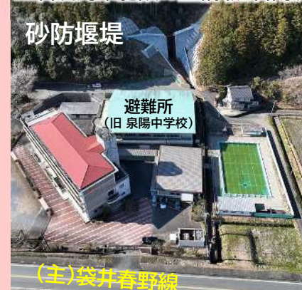
土石流対策施設の整備(黒石南沢)
