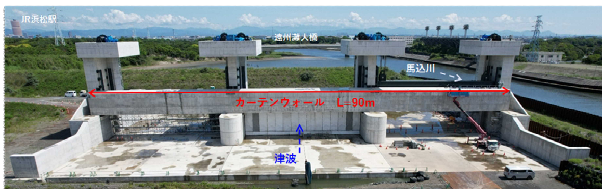
馬込川水門 整備状況（河口側から上流を望む）（令和7年5月現在）
