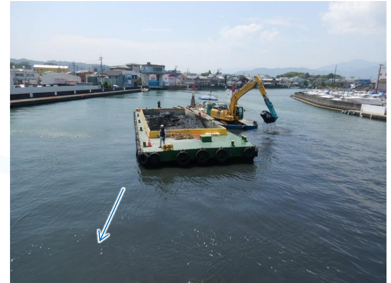
河道掘削状況
