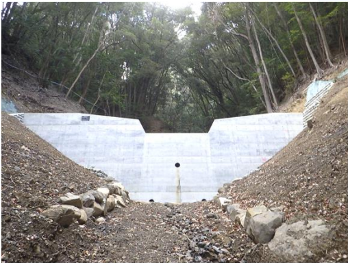
治山施設（谷止工）の設置
