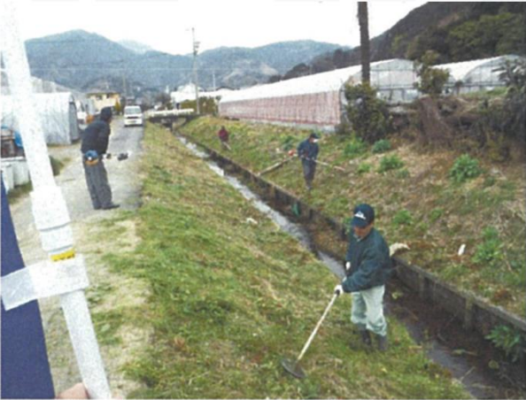
水路の保全活動(実施状況)
