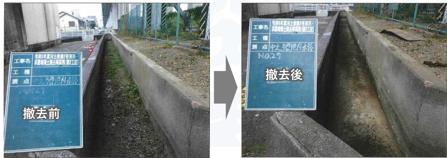
堆積した土砂を撤去
