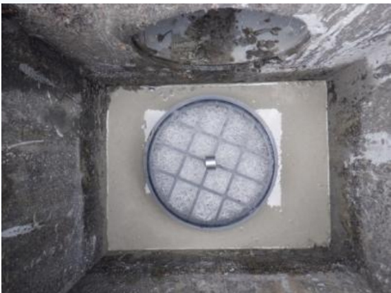
浸透施設整備後
