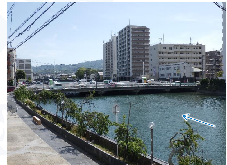
上流左岸から千歳橋を望む
