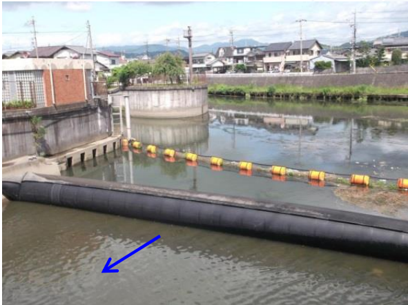
＜大谷川放水路 分流堰＞
