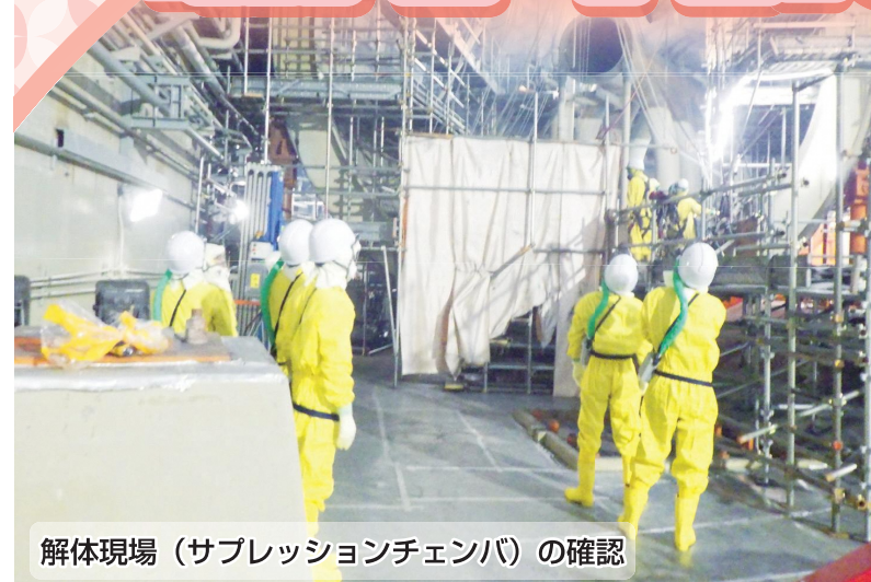
解体現場(サブプレッションチェンバ)の確認
