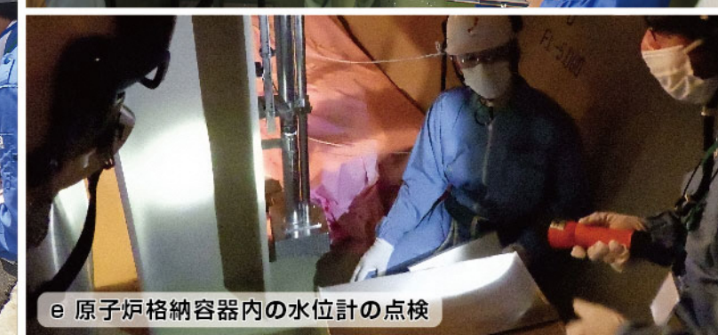
d 中央制御室の待機室の点検
