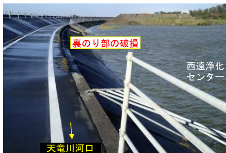
2013年10月の台風26号時の越波による被害状況
