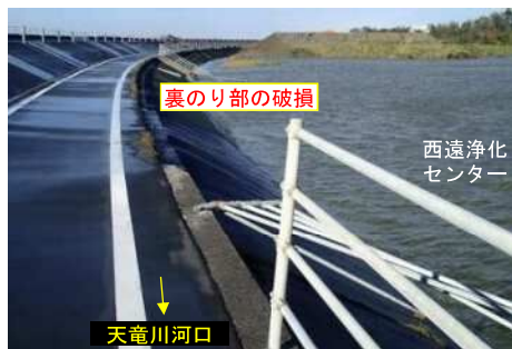
2013年10月の台風第26号時の越波による被害状況
