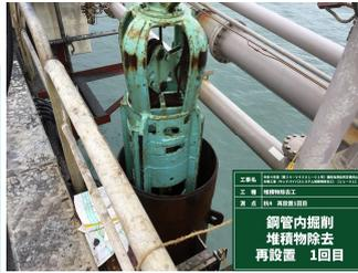
ハンマーグラブで鋼管の中を掘削し、地中内に堆積したゴミを除去
