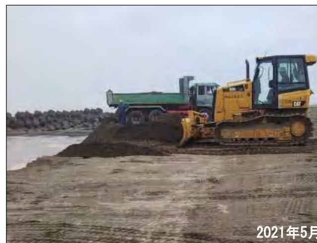
竜洋海岸の養浜実施状況（天竜川河道掘削土砂）
