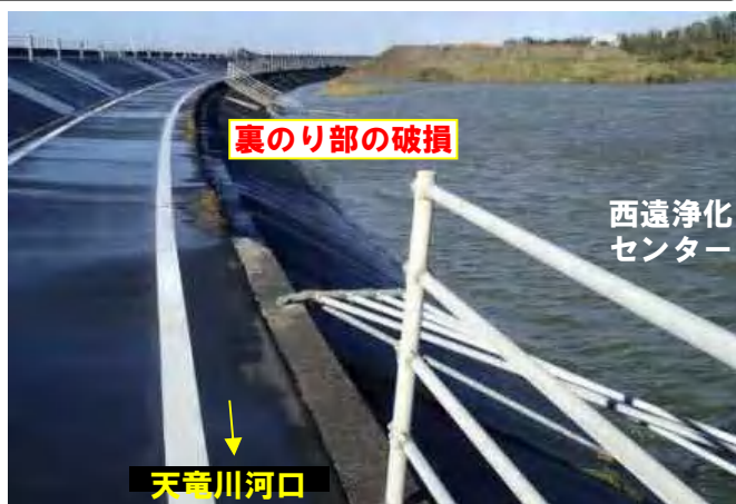
2013年10月の台風26号による 越波による被害状況
