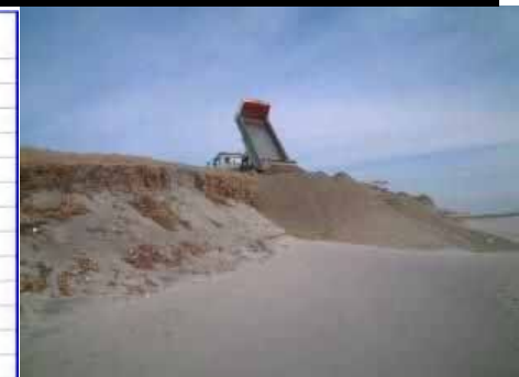
中田島海岸前面の 養浜投入状況
