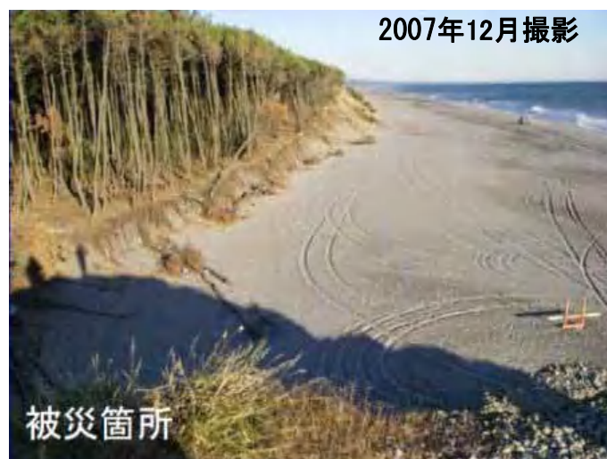
2007年7月の台風4号による 堤防（土堤）の侵食状況
