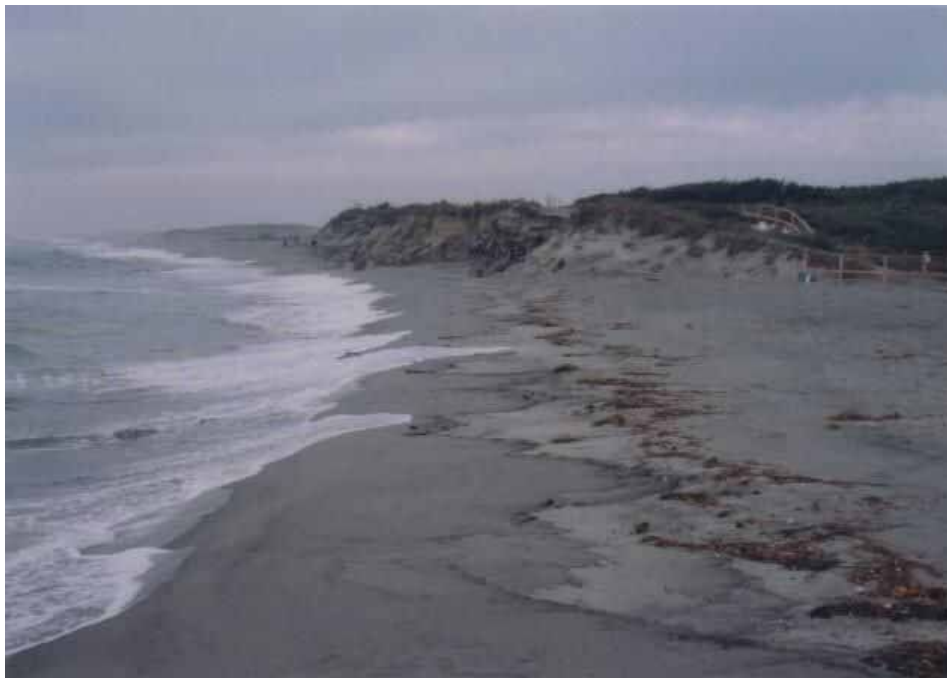
写真 中田島の侵食状況(平成15年10月)
