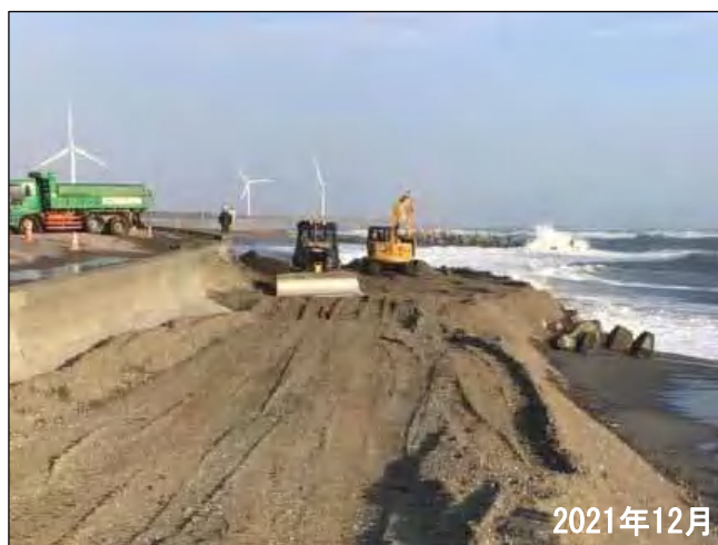
浜松五島海岸の養浜実施状況（天竜川河道掘削土砂）
