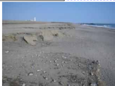
押土養浜実施後 押土箇所 (2011年9月 台風15号来襲後状況)
