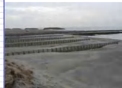
堆砂垣による 砂の捕捉状況
