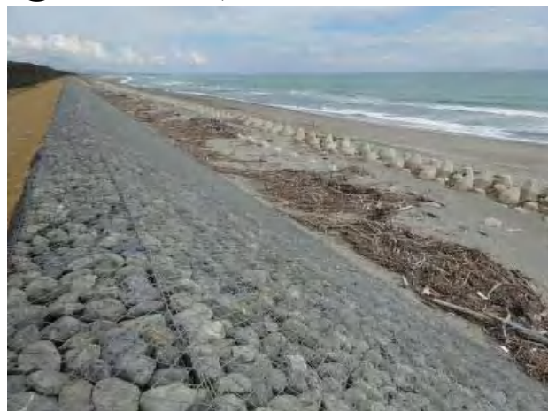
③6号離岸堤下手
