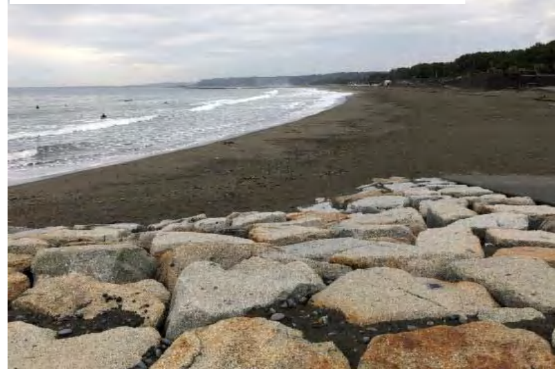
（静波突堤より南側）汀線際は砂質が覆っている
