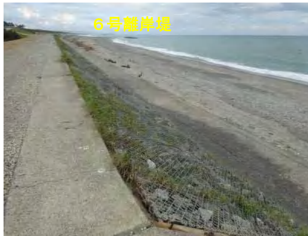
②6号離岸堤上手
