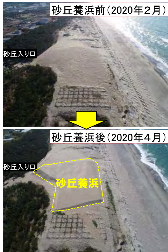
砂丘部への養浜実施状況 (2020年に10,700m 3 投入)
