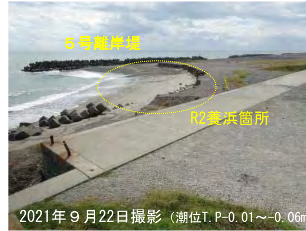
①R2養浜実施箇所
