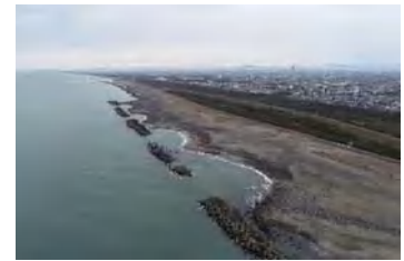
浜松五島海岸 4号離岸堤ブロック散乱
