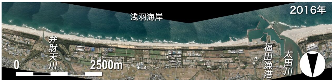
福田漁港から弁財天川河口間の空中写真（1946年，2016年）
