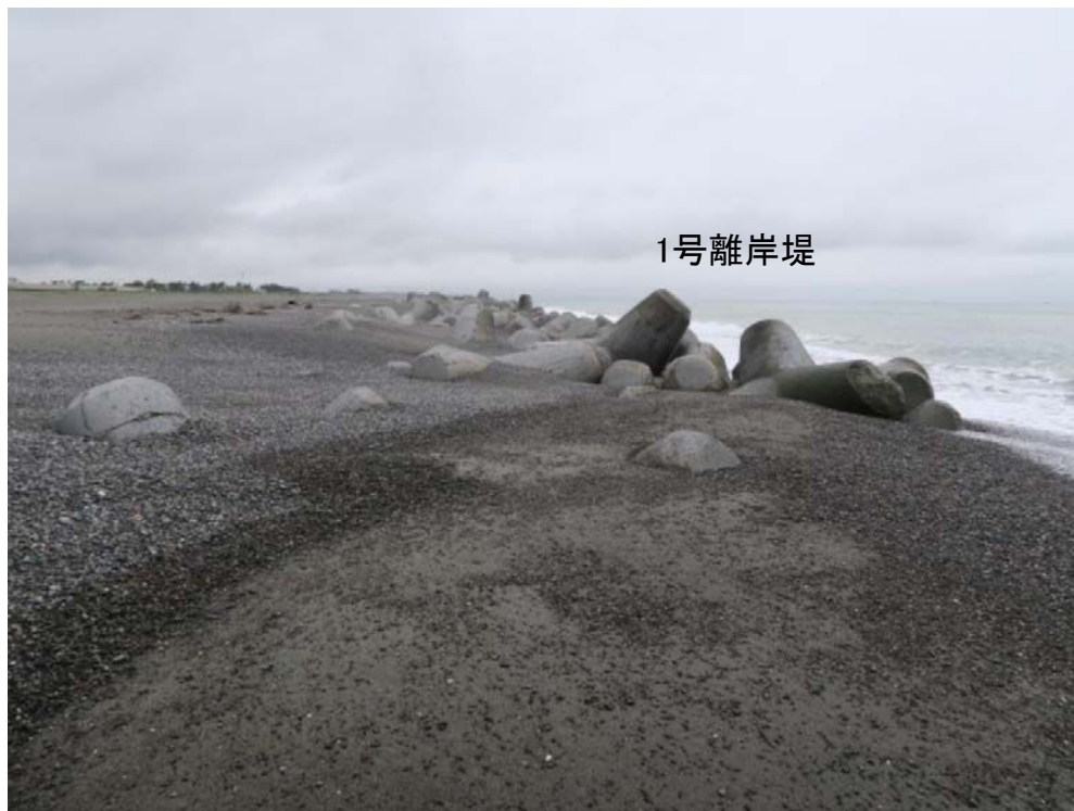
竜洋海岸の1号離岸堤の西端状況（2018年5月8日）
