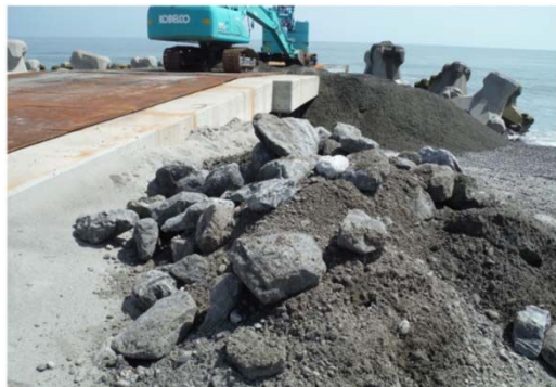
海側の突堤設置予定箇所に転石が散乱しており、計画どおり矢板を打設して突堤を築造することが困難な状況。
