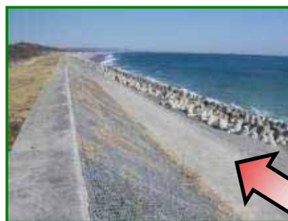
離岸堤下手に侵食波及 (砂浜消失)
