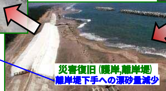
離岸堤下手に侵食波及 (砂浜消失)
