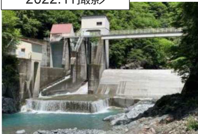
木賊えん堤（全景 下流より望む）
