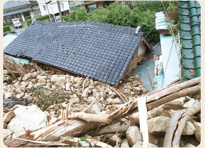
▲令和4年8月に発生したがけ崩れ(松崎町)
