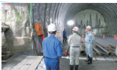
▲昨年10月に行った鈴木知事の山梨工区ボーリング現場視察の様子
