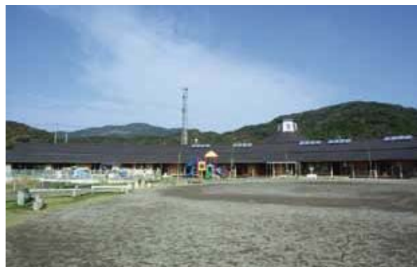
広い園庭と木造園舎
