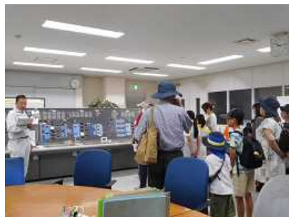
中央監視室の見学
