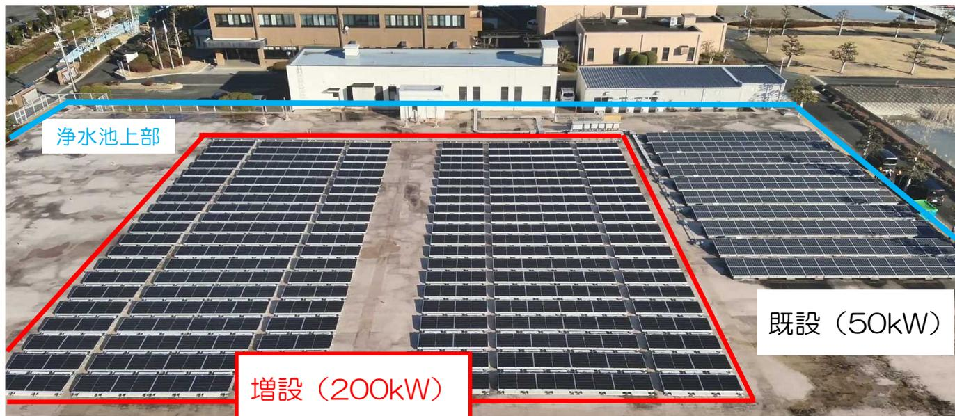
再生可能エネルギーの活用による脱炭素化の取組として、都田浄水場浄水池の上部を有効利用し、太陽光発電設備（200kW）を増設しました。増設費用の財源として、公営企業債（脱炭素化推進事業）、環境省補助金（省CO2化普及加速事業）を活用しました。
