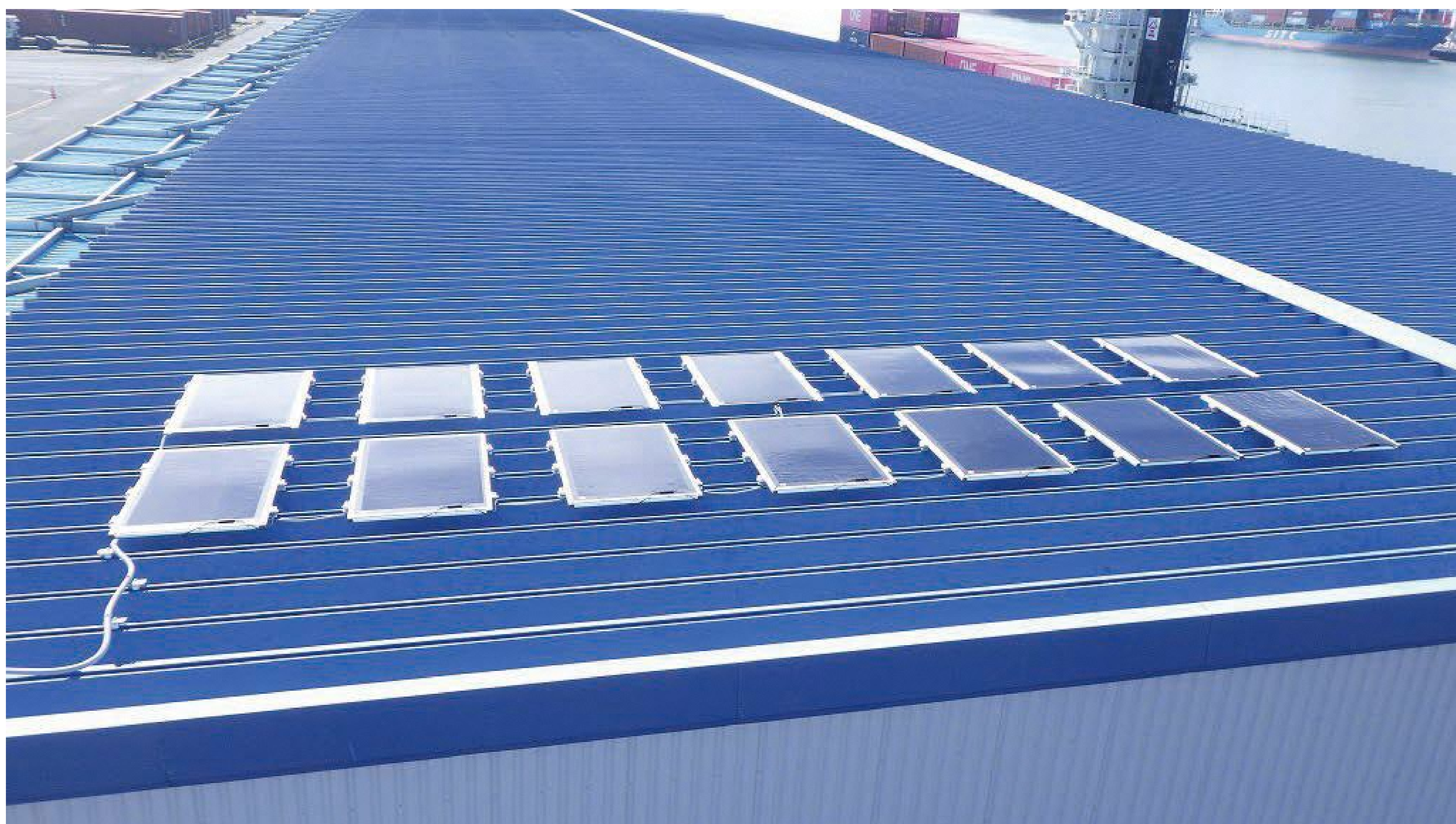
▲興津13号上屋の屋根に太陽電池14枚を設置
