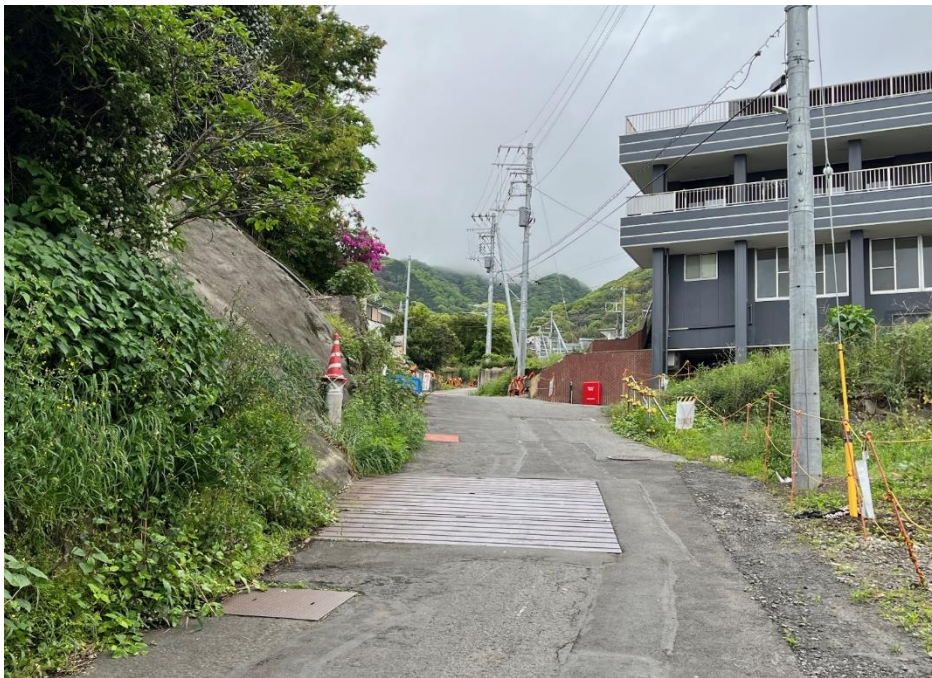
下流側（起点）から上流側を撮影
