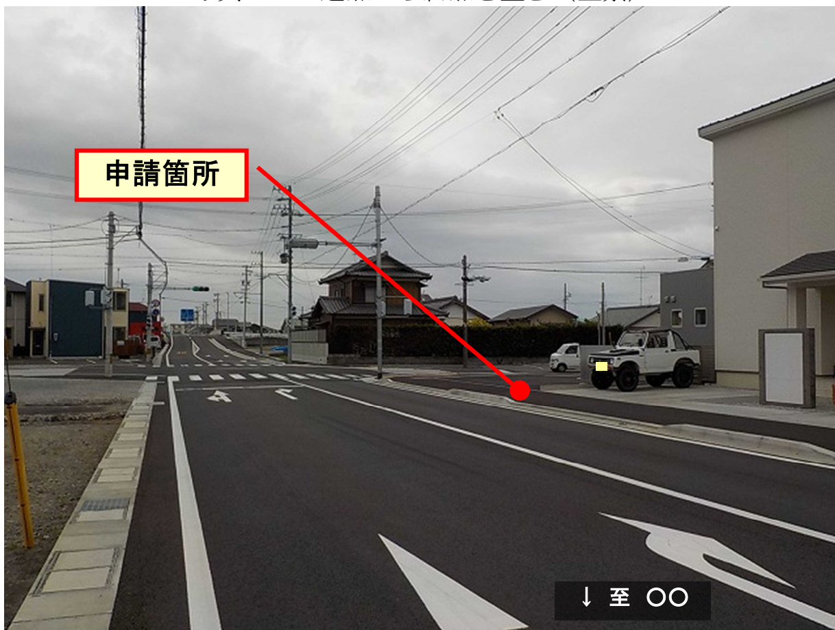
写真-2 終点から起点を望む (全景)
