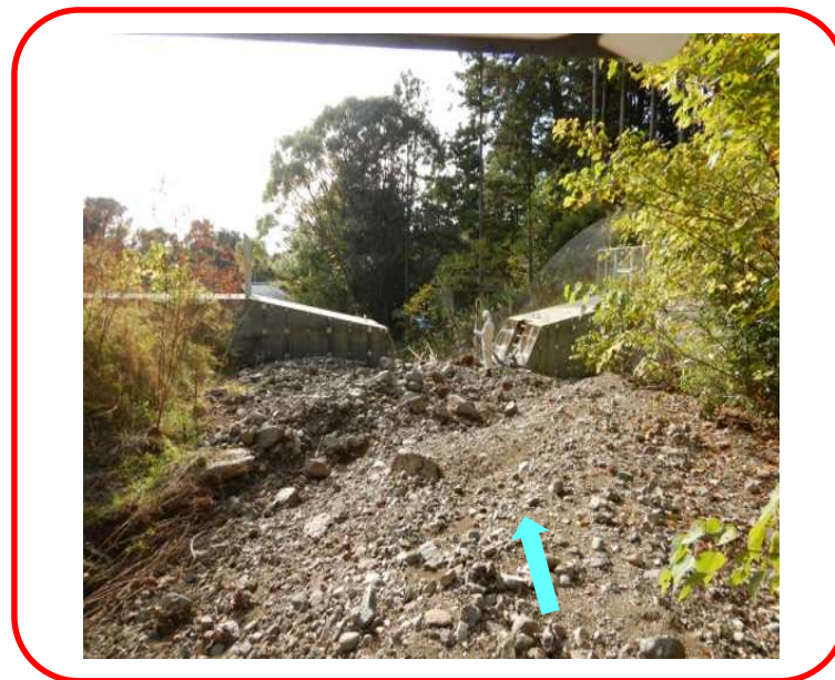
土石流発生後 (R4.9.24)
