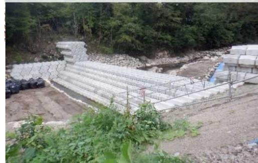
砂防堰堤の新設(設置イメージ)
