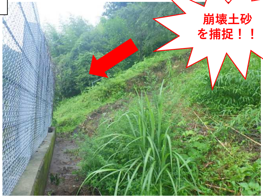
急傾斜地崩壊防止施設 (落石防護柵及び擁壁)
