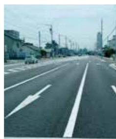
▲片側1車線を2車線にした道路
