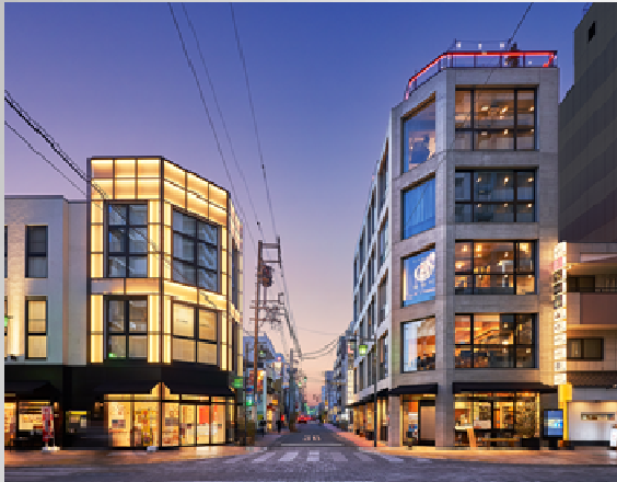
静岡市葵区人宿町の事例
