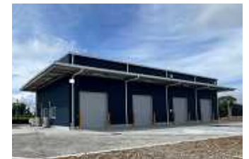
カンショ長期貯蔵施設の整備
