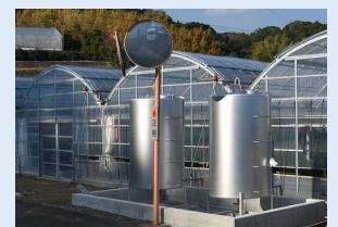
LED照射可能な新規施設
