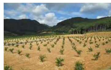
三ヶ日みかんの里地区 日比沢工区（農地造成）
