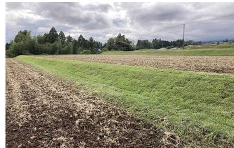
吹き付け3ヶ月後の被覆状況
