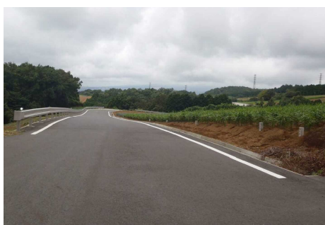
農道整備の状況
