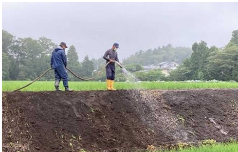
吹き付けの様子
