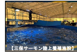
【三保サーモン陸上養殖施設】
