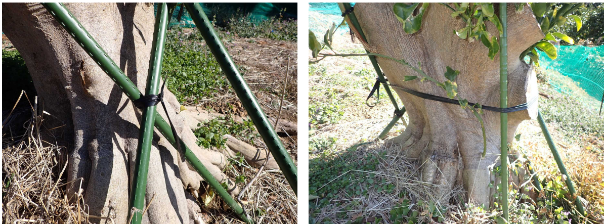
図9 支柱が倒れないための工夫
