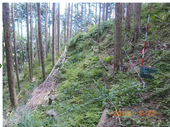
整備 3 年後（平成 25 年）
