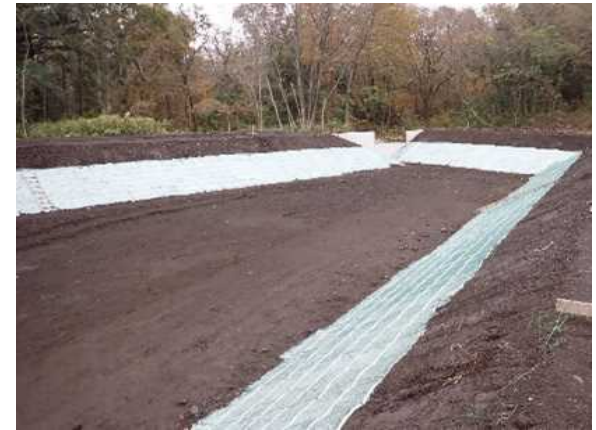
仮設防災調整池の設置例
